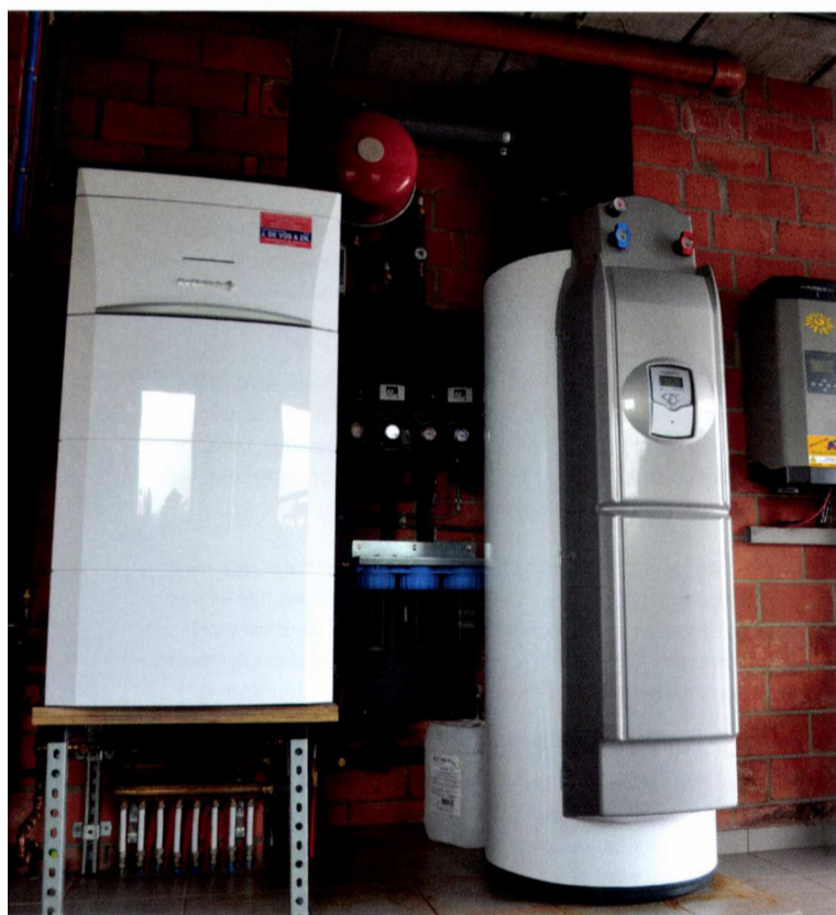
De eigenaar van deze ruime, groene villa opteerde voor een stookoliecondensatieketel in combinatie met een zonneboiler.
